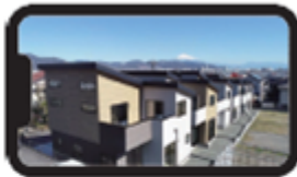
(ドローンからの空撮)
